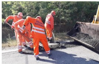
Racirea mixturii până la punerea în opera cauzează compactare necorespunzătoare
