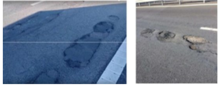
Dislocare plombe realizate cu mixtură stocabila
