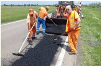
Racirea mixturii până la punerea în opera cauzează compactare necorespunzătoare
