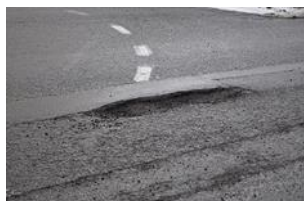
Rostul de lucru neetanș este originea dezvoltării gropilor adiacente plombelor
