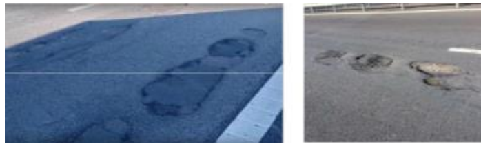
Dislocare plombe realizate cu mixtură
