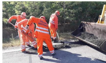
Mixtură asfaltică răcită până la punerea în opera cauzează compactare necorespunzătoare
