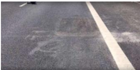
Plomba cu „rosturi” etanșe realizată cu Tehnologia IR ( infraroșu )
