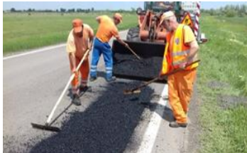
Mixtură asfaltică răcită până la punerea în opera cauzează compactare necorespunzătoare
